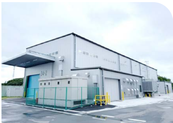
新しい圧縮機試験棟
