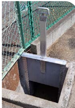
油漏洩対策の仕切り板
