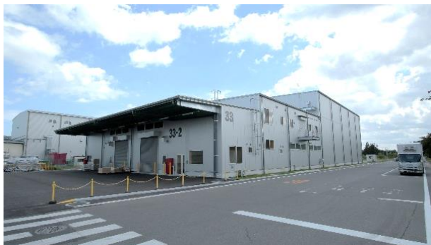
1,500パレット、14,000バケットを収容する新自動倉庫
